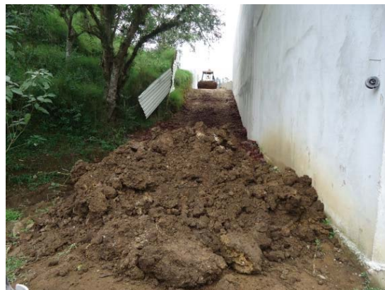
Imagen 13. Trabajos en el acceso al área de reforestación.
