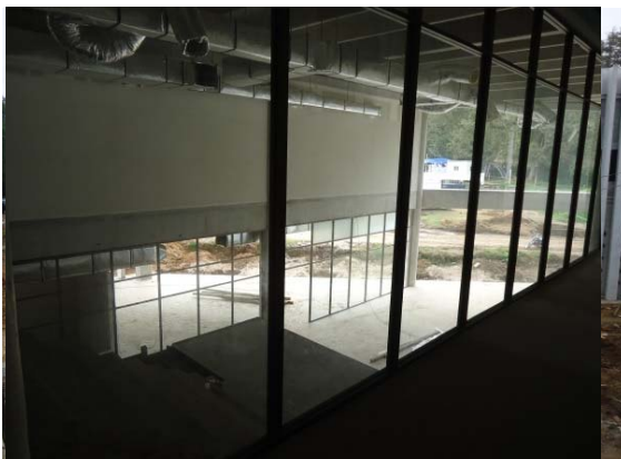
Imagen 5. Trabajos de cancelación en la planta alta, en el perímetro del edificio.
