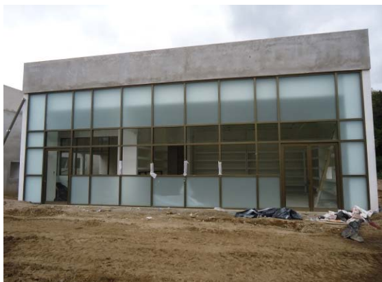
Imagen 14. Fachada Sur-Poniente en el edificio "D".
