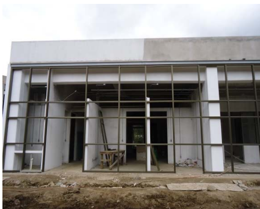
Imagen 11. Trabajos de cancelería en el Laboratorio de Micropropagación.
