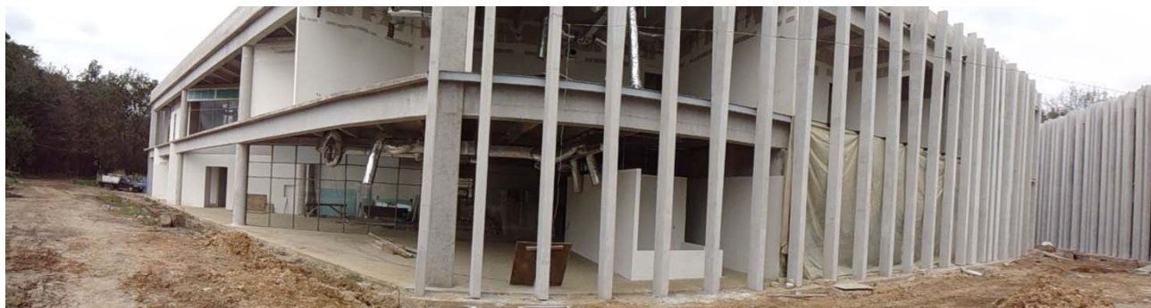
Imagen 4. Vista panorámica de avance del Edificio “A”.
