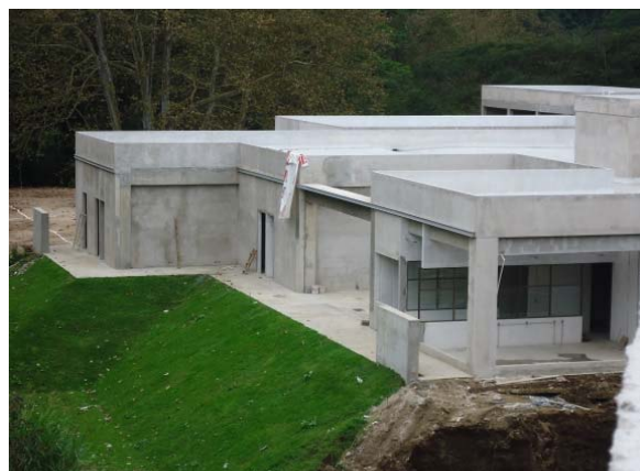
Imagen 12. Vista de fachada Nor-Oriente.
