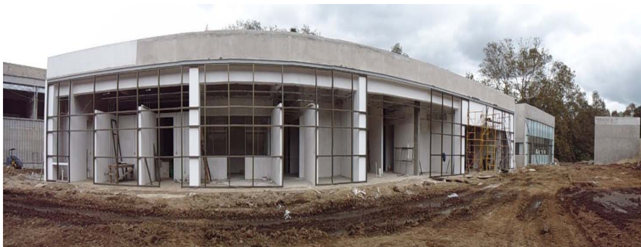
Imagen 10. Vista panorámica del avance general del edificio “C”.
