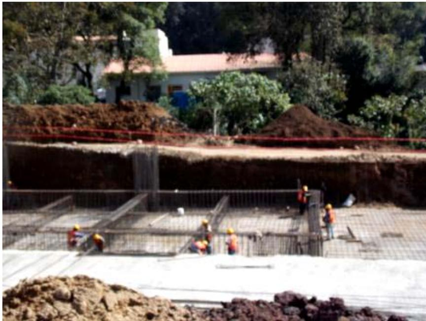
En el edificio “B” se terminó la excavación de los tres niveles de plataforma, caso particular en el nivel -5.00 en los ejes (15-17) y (a-c) el mejoramiento del terreno se hizo en una capa de 50cm. promedio de grava en greña o tezontle, para canalizar el agua que brota en esta zona hacia el río y otra de tepetate compactado.
