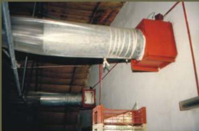
Fig. 26. Sistema de ventilación con ducto de plástico perforado para permitir una distribución homogénea del aire.
